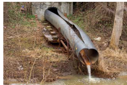
Често отпадне воде из индустријских комплекса завршавају у рекама.
